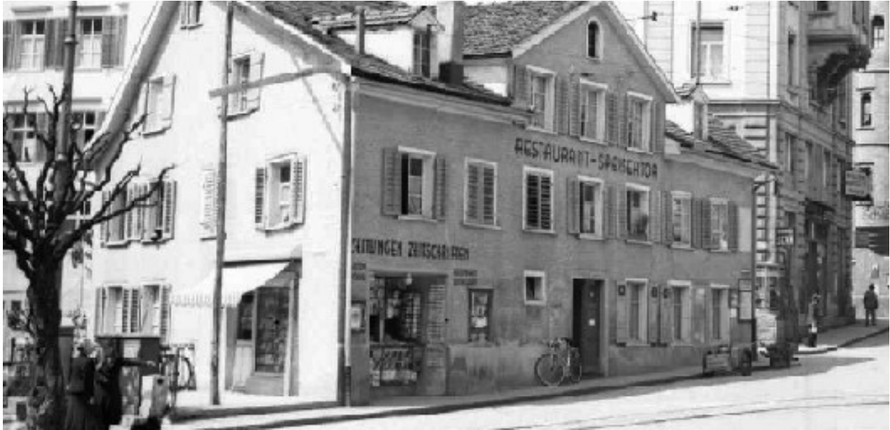
Ehem. Rest. Spisertor, Burggraben 2, 9000 St. Gallen (1950)
