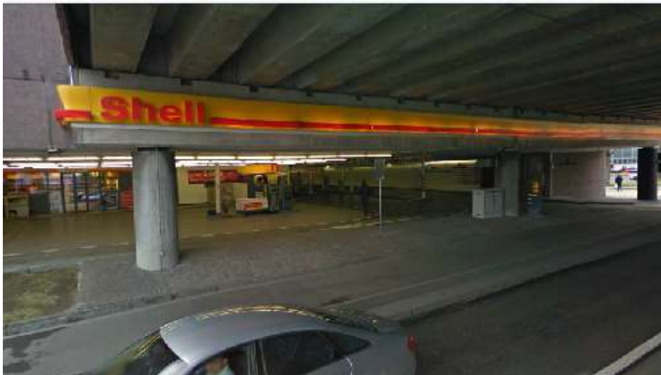
Tankstelle unter Strassenviadukt, 8004 Zürich
