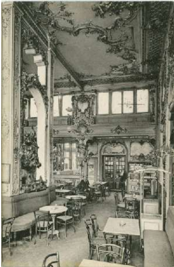
Ehem. Rest. Metropol, Fraumünsterstr. 12, 8001 Zürich
